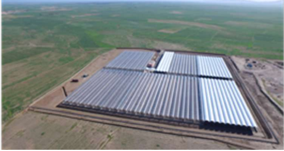
الصورة 1.1 محطة تجفيف الحمأة الشمسية.. المصدر: الوكالة المستقلة لتوزيع الماء والكهرباء بمراكش (راديم).
