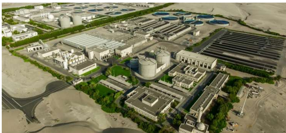
الصورة 8.1 محطة معالجة مياه الصرف الصحي في الوثبة-2.
