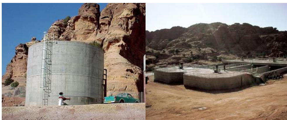
الصورة 7.2 خزانات التهوية (على اليسار)، وصهاريج التخزين (على اليمين) بمحطة معالجة مياه الصرف الصحي بوادي موسى
